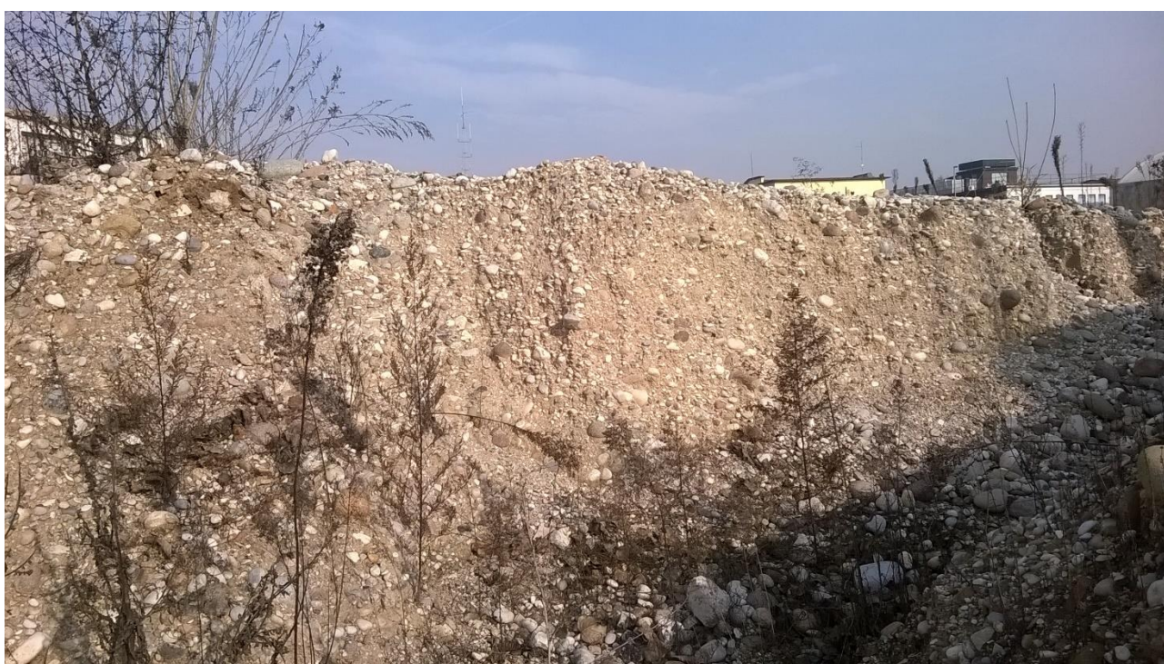
Fig. 3: Fronte di scavo profondo 3 m ed eseguito internamente al lotto in progetto.
